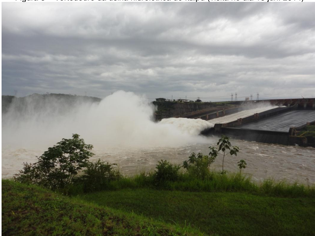
Figura 3 – Vertedouro da usina hidrelétrica de Itaipu (visita no dia 13 jun. 2014)
