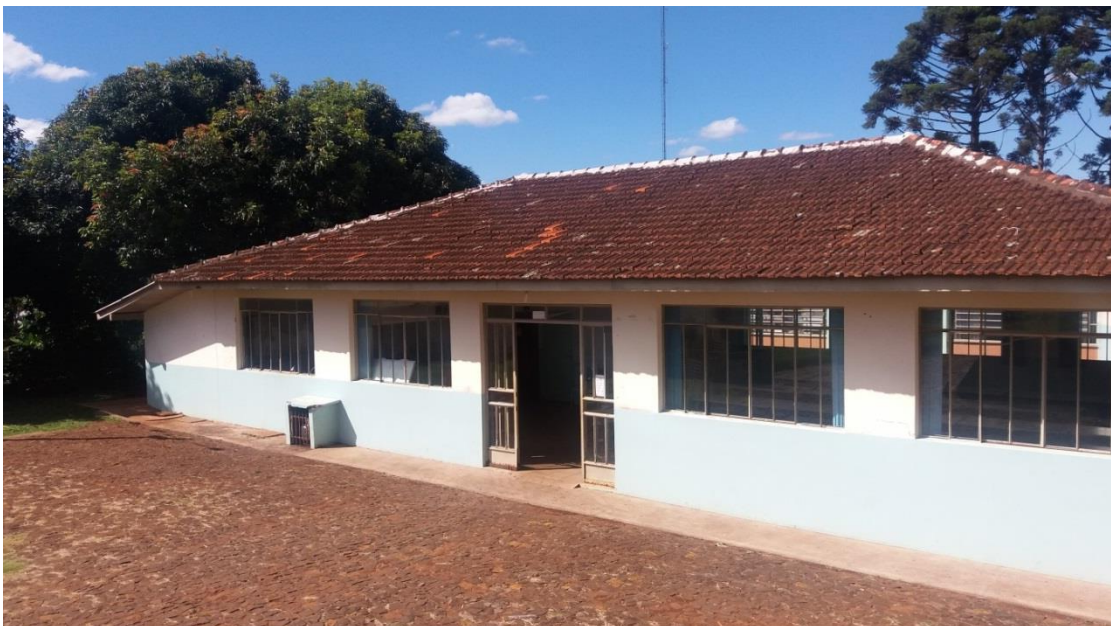
Figura 4 - Refeitório - Col. Est. General Carneiro –E.F.M.P. Fonte: A autora
